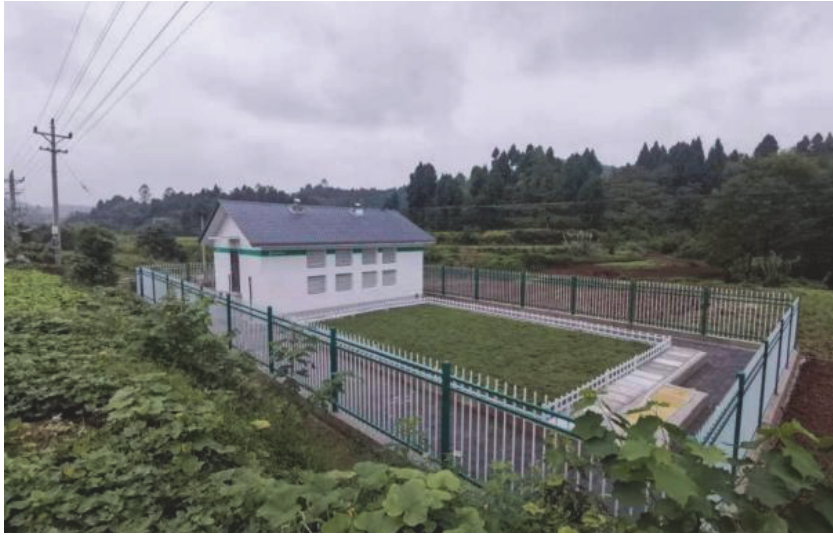
图 2-2 “淋滤塔+生物滤床” 应用场景图
