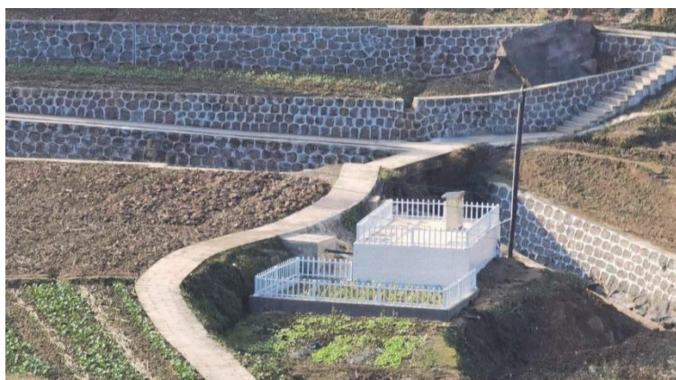
图 1-5 南江县天关村“户用小三格式化粪池+厌氧滤池+贮存池+资源化利用”应用实景图
