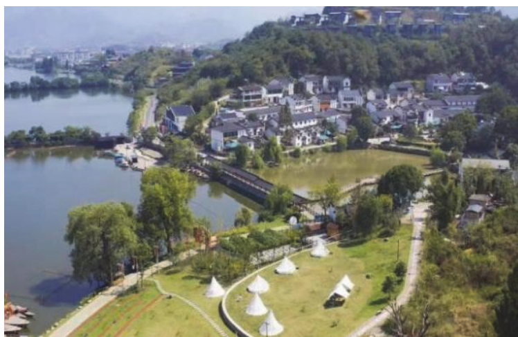
图 4-4 建德市三都镇三江口村污水处理终端站点
